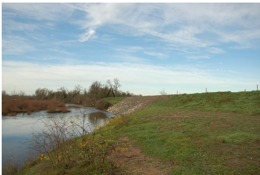
Création d'un chemin d'accès avec enrochement de la digue après le domaine de la Crevée. La circulation sur la digue est à nouveau autorisée dans ce secteur.
