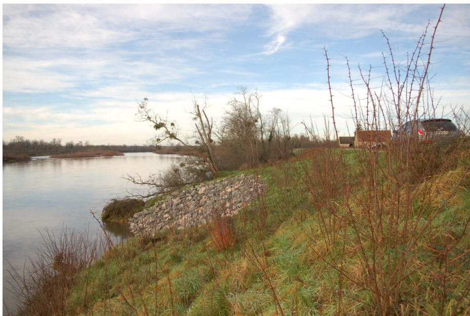
Un enrochement et la reconstitution de la digue avant le domaine de la Crevée.
